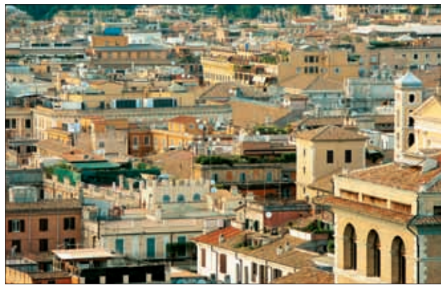
I tetti di Roma contaminati da antenne e parabole
