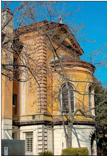
Trento, l'abside della chiesa del carcere destinato a demolizione
