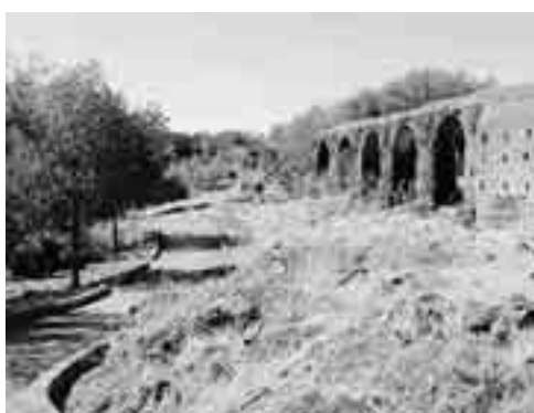
IL PARCO GIOENI. All'interno del parco sono evidenti saie, canali e strutture, molte delle quali sono crollate o a rischio e necessitano un pronto restauro
