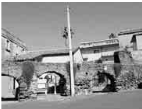
GLI ARCHI DI CIBALI. La sorgente di Cifali, da Kefalé - testa dell'acqua - nasce poco sopra piazza Bonadies dove è tutt'ora visibile parte dell'acquedotto
