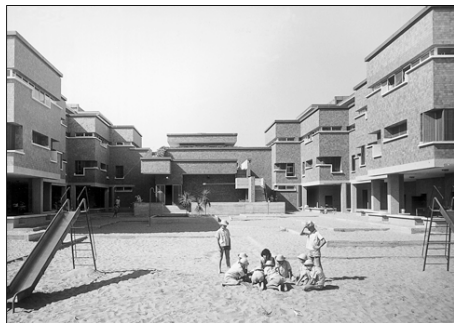
In alto la colonia Sip-Enel allo stato attuale (fotografia di Federico Tomasini); sopra la colonia negli anni sessanta (© Studio De Carlo)
