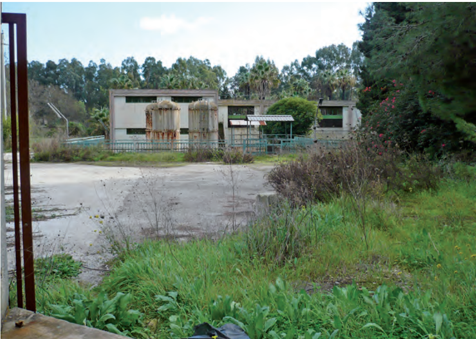
Centrale di sollevamento (lettera f)
