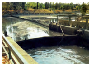
Paratoie dell'impianto di derivazione Foto C. Basile
