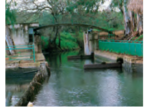
Attraversamento pedonale all'altezza delle paratoie Foto C. Basile
