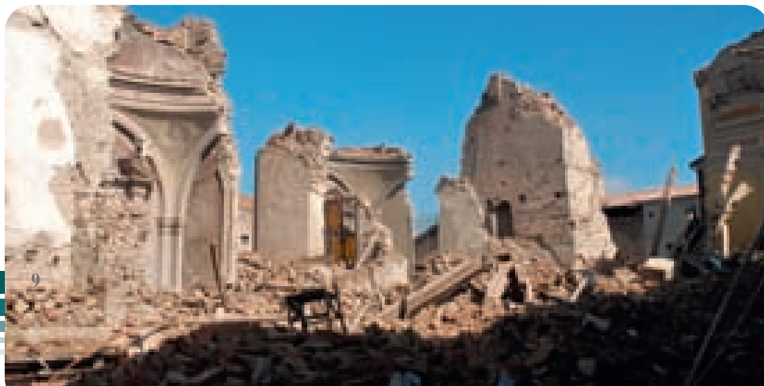
TERREMOTO IN EMILIA La chiesa di San Felice sul Panaro quasi completamente distrutta. Foto ricevuta da Maria Pia Guermandi
