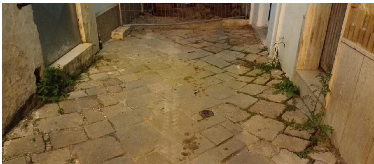
2 - Racale via Umberto I, basolatura originale prima dei recenti lavori.
