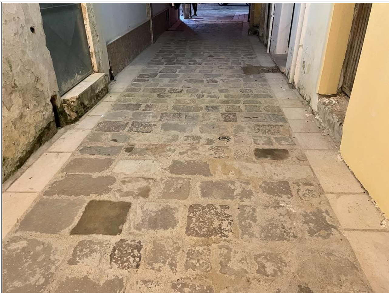
3 - Racale via Umberto I, basolatura attuale recentemente rifatta.
