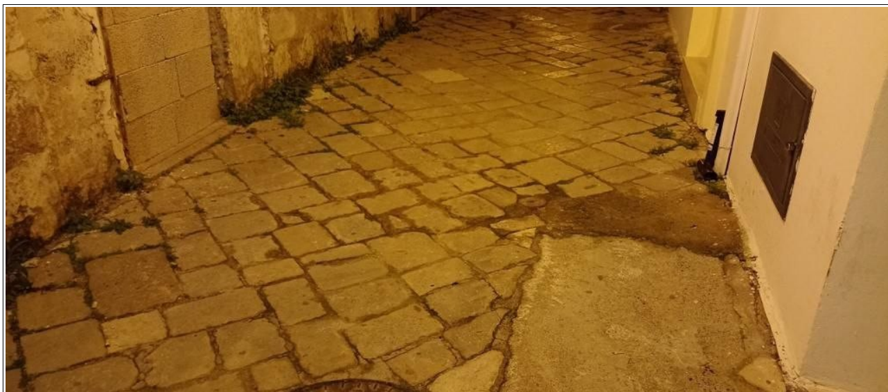
1 - Racale via Umberto I, basolatura originale prima dei recenti lavori.
