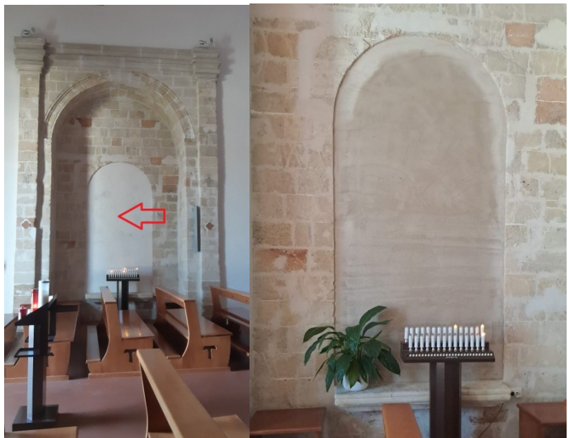
Situazione attuale della nicchia murata.
