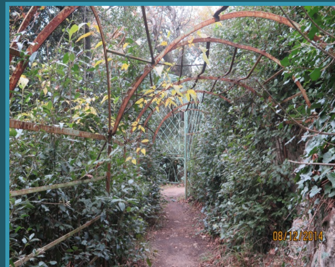
6) Pergolati danneggiati da anni, ora riparati.
