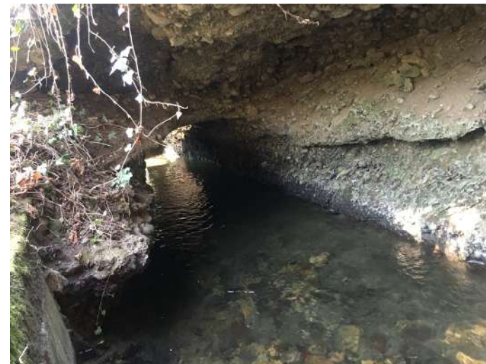
Il canale scavato nel «macigno»
