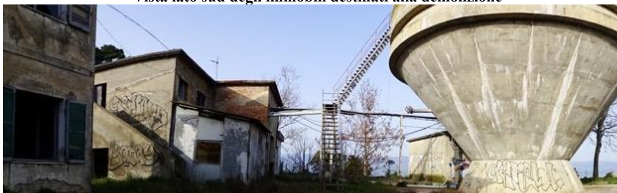
Vista lato sud degli immobili destinati alla demolizione
