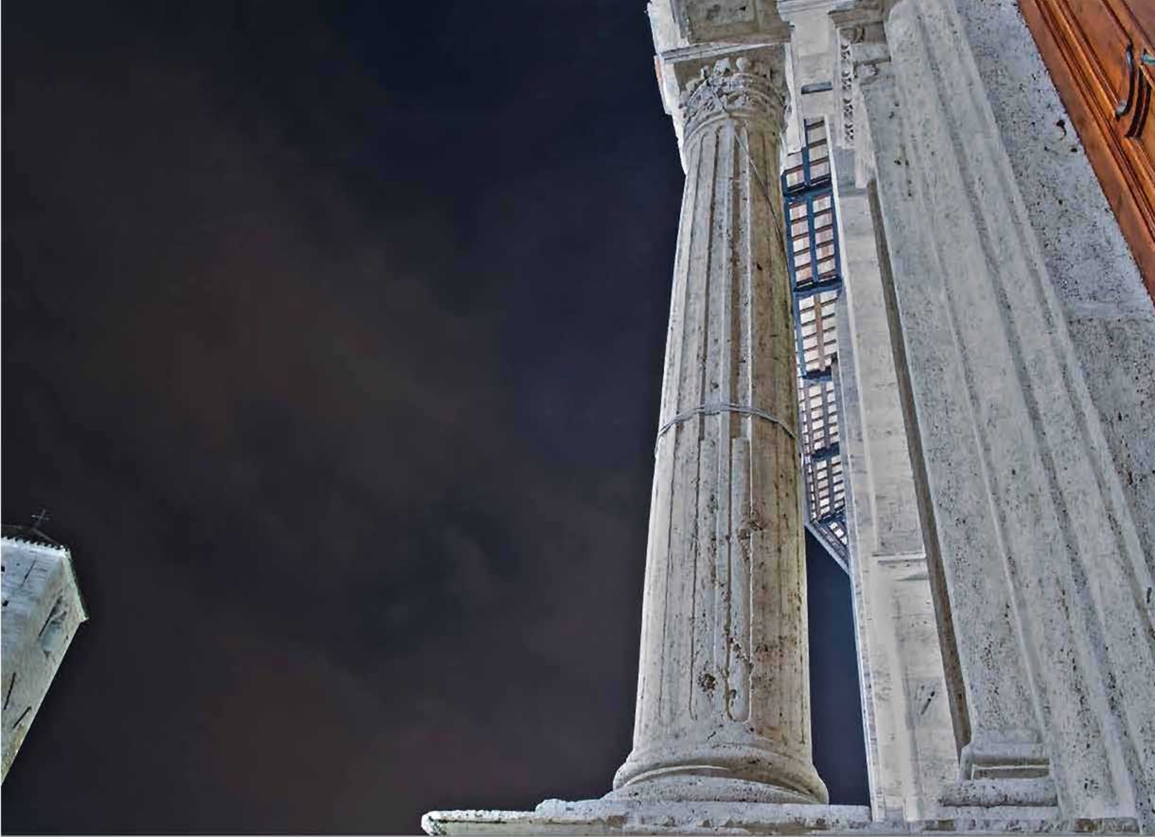
Particolare di Piazza Ventidio Basso
