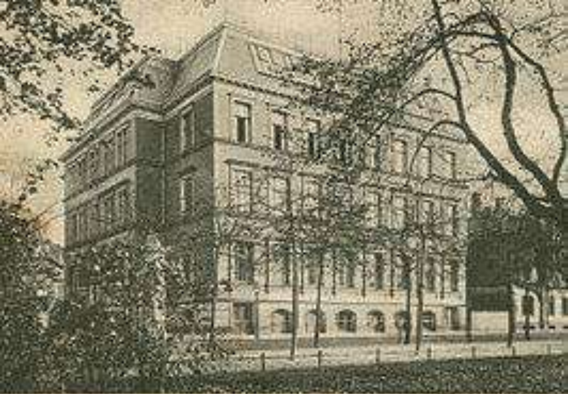
Hannover, Aufstiegsgebäude, 21. August 1899.
