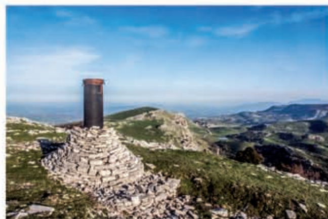
Acquedotto sulla Montagnola (Foto di F. Di Palma)
