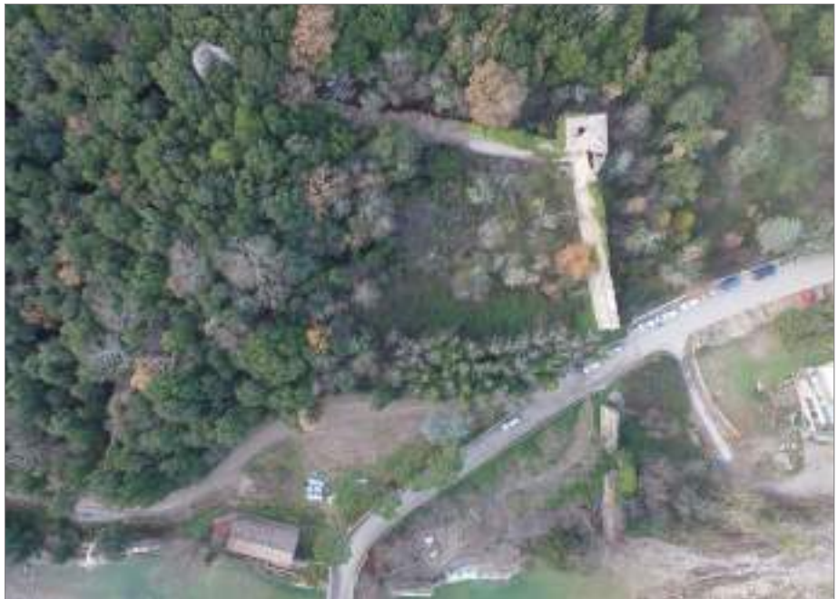
VISTA AEREA BAGNI DI PETRIOLO IN FASE DI RESTAURO
