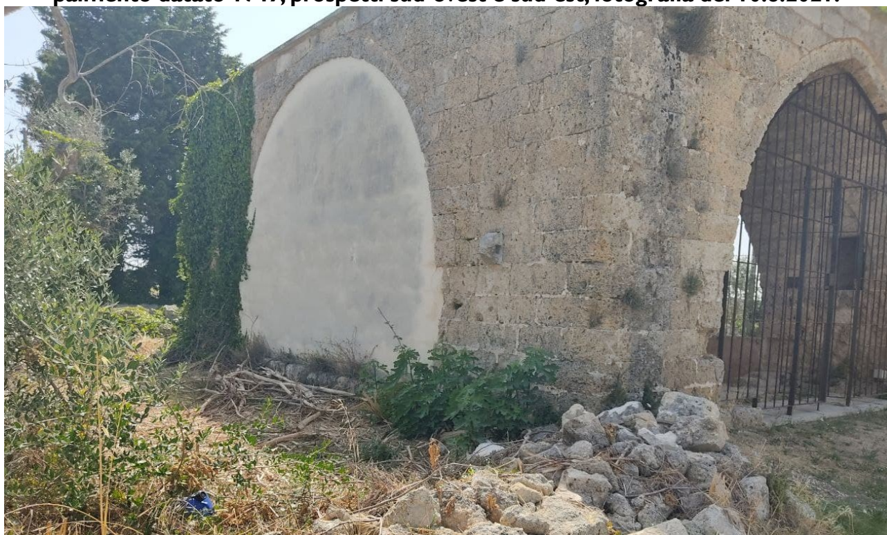
I1- Collepazzo, via Corsica già strada provinciale per Galatina, palmento datato 1749, prospetti nord-ovest e sud-ovest, fotografia del 10.8.2021.
