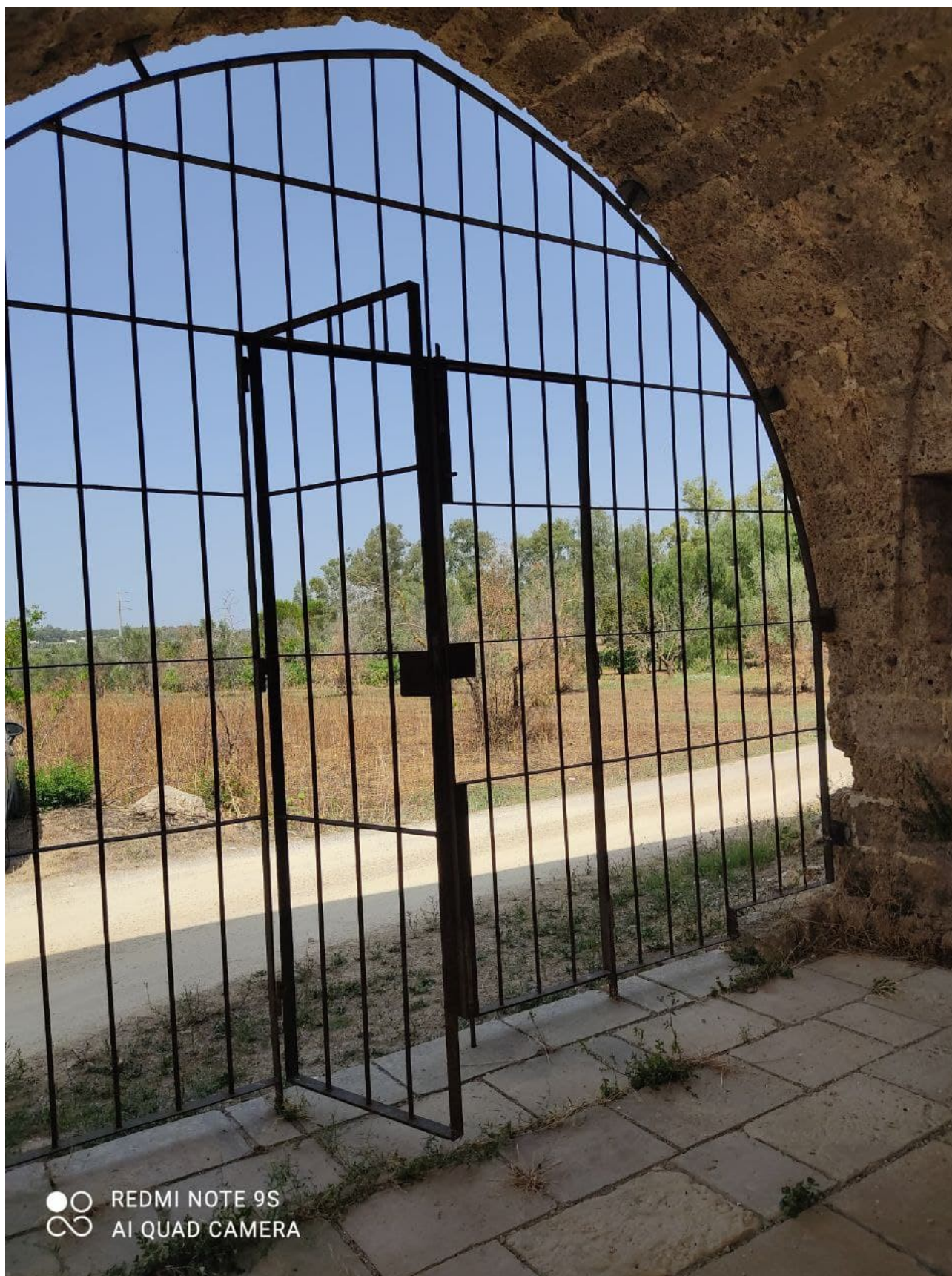
I2- Collepasso, via Corsica già strada provinciale per Galatina, palmento datato 1749, veduta interna verso sud-ovest, fotografia del 10.8.2021.
