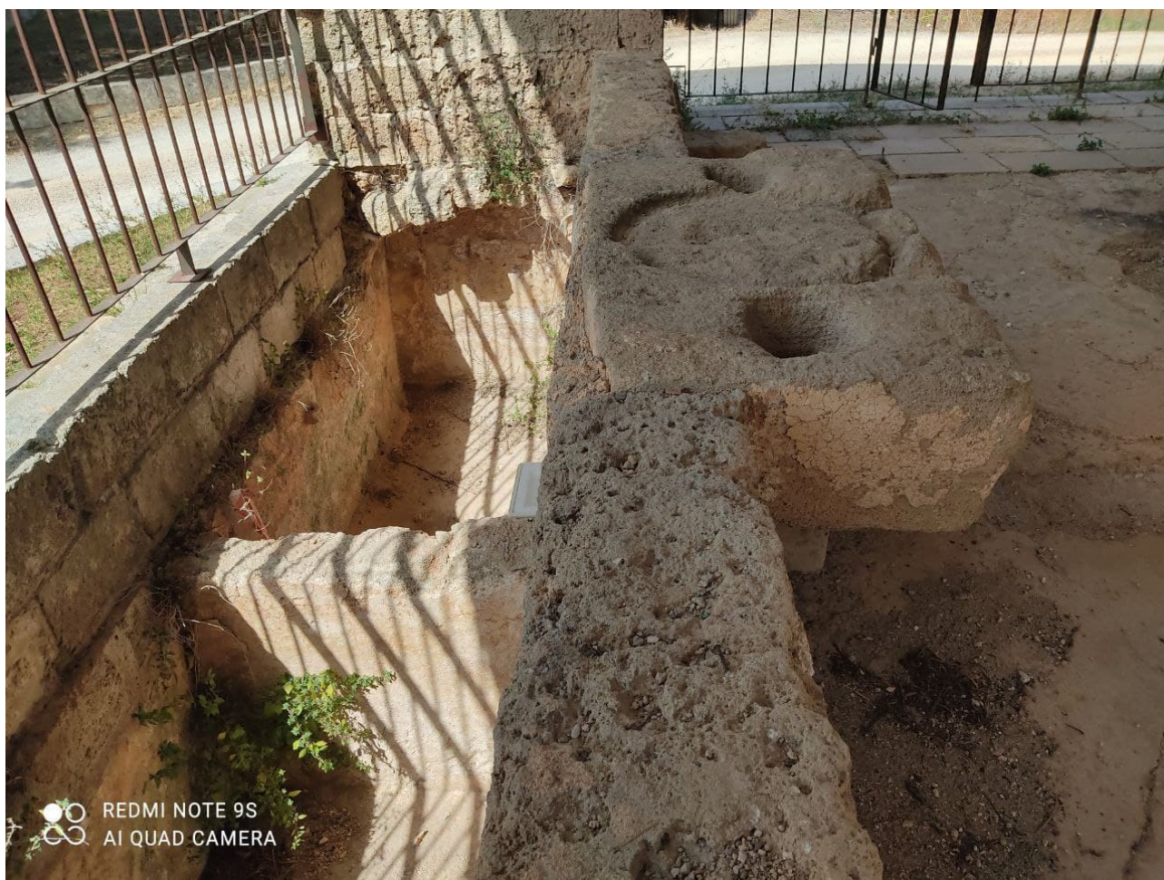
18- Collepazzo, via Corsica già strada provinciale per Galatina, palmento datato 1749, veduta interna delle vasche e della base del torchio, fotografia del 10.8.2021.
