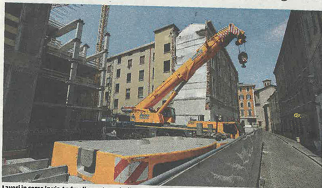
Lavori in corso in via Andreoli: presto anche il palazzo delle ex Poste all'angolo con via Sessi sarà demolito
