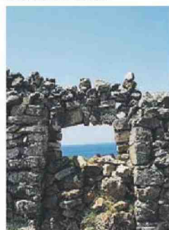
Muretti a secco
