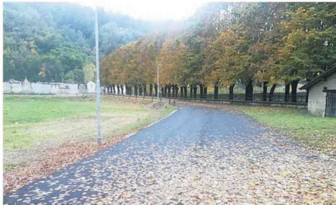
La strada alternativa verso il cimitero è stata asfaltata e illuminata
