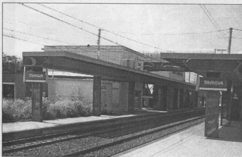
A sinistra e sopra le stazioni di Siracusa centrale e Targia, inutilmente ristrutturata nel 1998, e un traghetto delle FS sullo Stretto di Messina, da giugno a mezzo servizio
