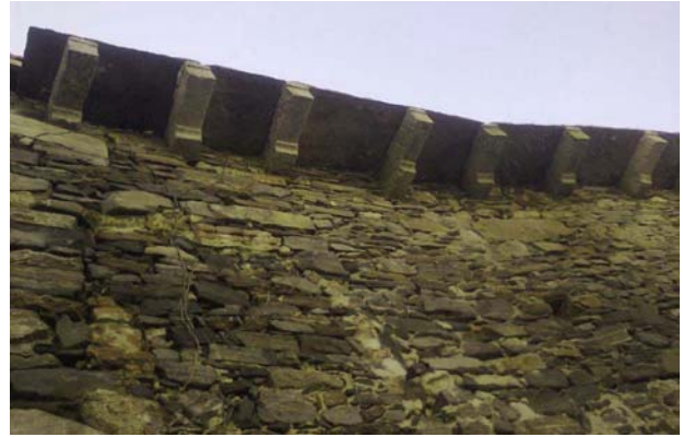
14. Parete e gronda, sostenuta da mensole in granito del sec. XVI, di uno degli edifici del nucleo tardomedievale "della Bifora".
