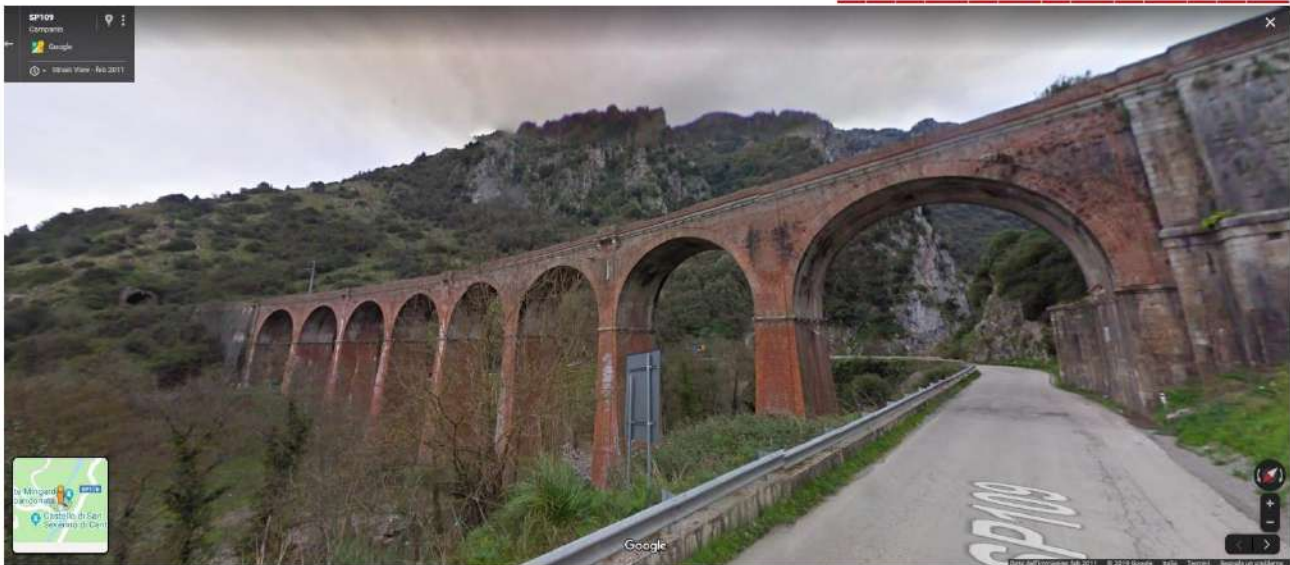
San Severino – un tratto del vecchio tracciato ferroviario
