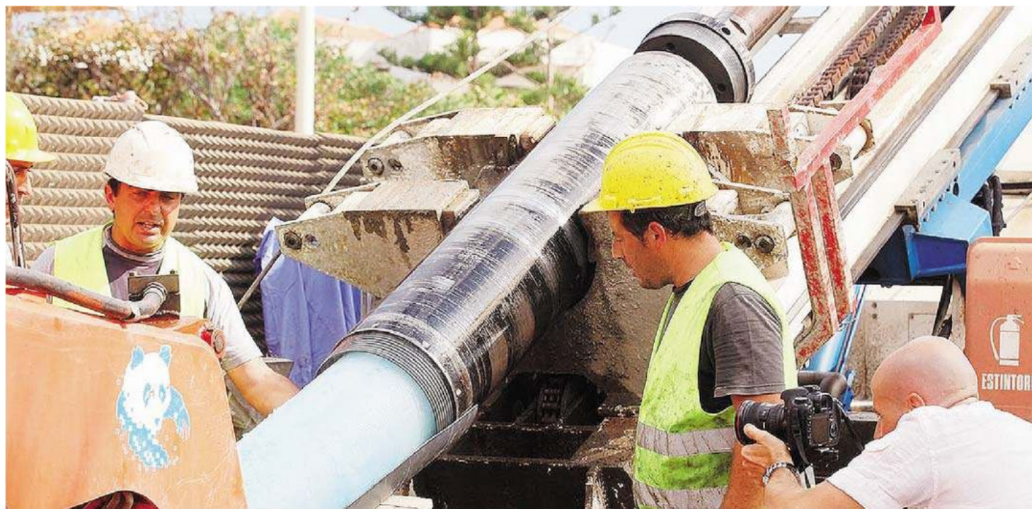
Una foto che potrebbe diventare storica se il Ponte non si farà: la trivella di Eurolink espelle il primo cilindro di materiale prelevato a meno 32 metri congelato grazie all'uso nelle perforazioni di azoto liquido a Torre Faro
