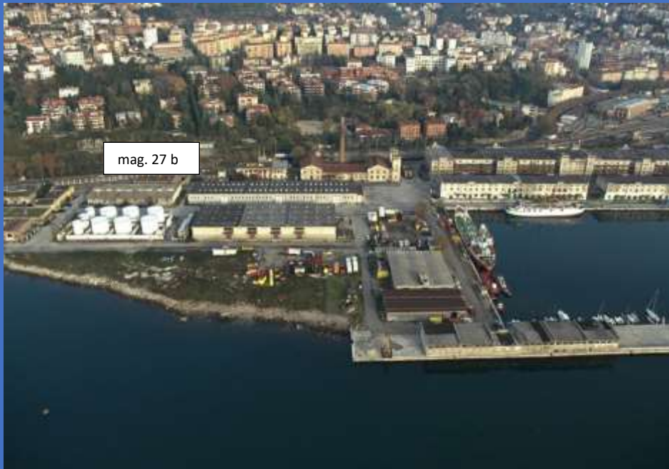
In questa foto del 2002, il magazzino 27b, a sinistra, tra il magazzino 27 e l'area SO.DO.VEA ( ora demolita per creare spazi per il Centro congressi)
