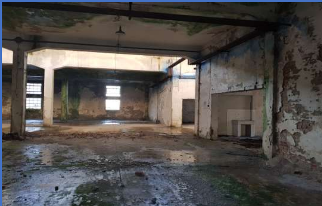
L'impianto basilicale a tre campate, più due laterali, con pilastri costruiti con il sistema Hennebique.
