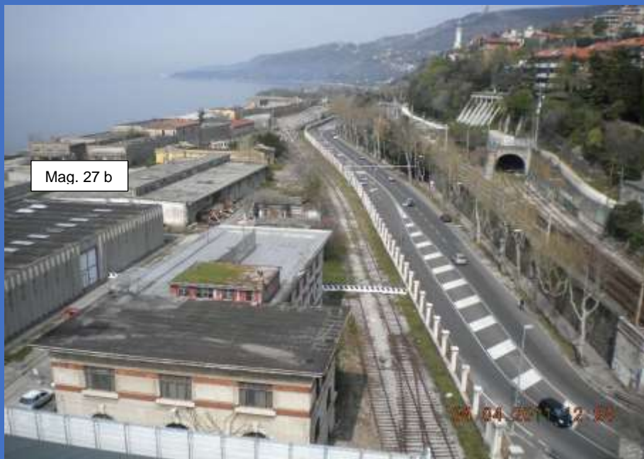
2011 - Il magazzino 27b, tra il magazzino 27, la sottostazione elettrica e l'area di smistamento ferroviario prima della demolizione di quest'ultima (2019)
