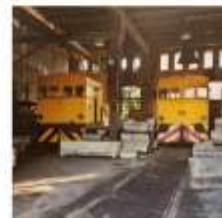
3 Ex Rimessa Locomotive Porto Vecchio - Trieste maggio 2019
