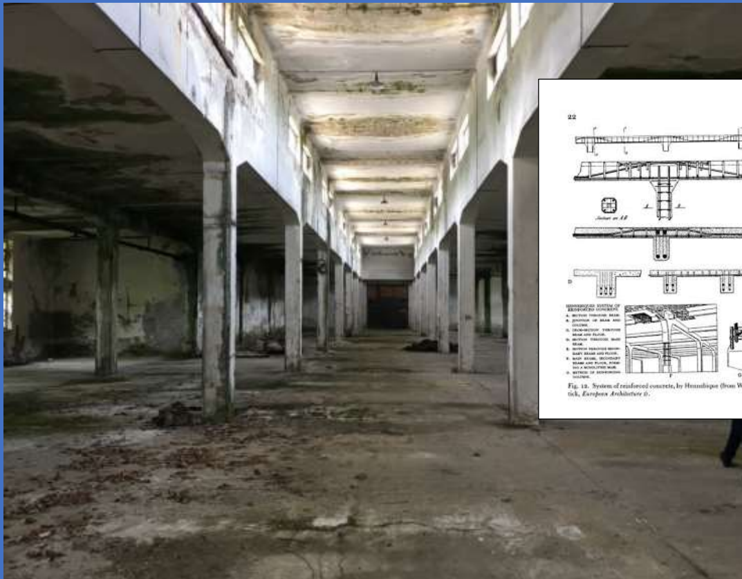
Lucernaio centrale e pilastri - Struttura in cemento armato Sistema Hennebique
