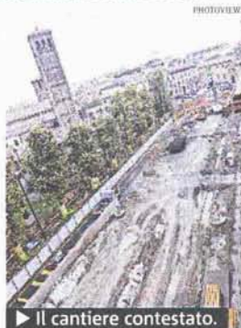
► Il cantiere contestato.
