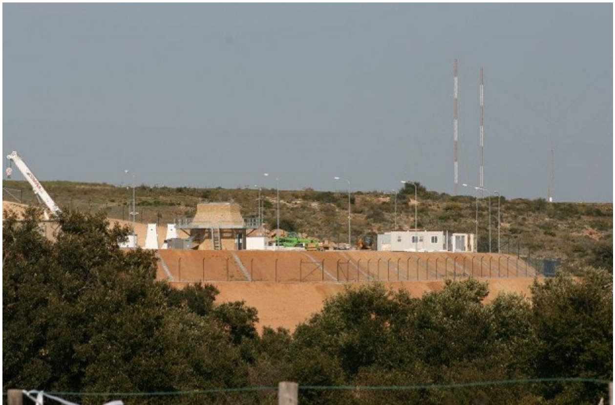
Contrada Ulmo: costruzioni delle installazioni radar
