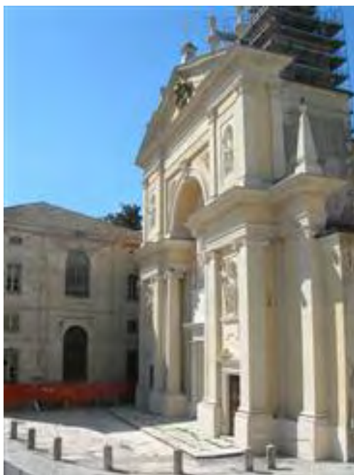
San Liborio appena restaurata, prima del sisma
