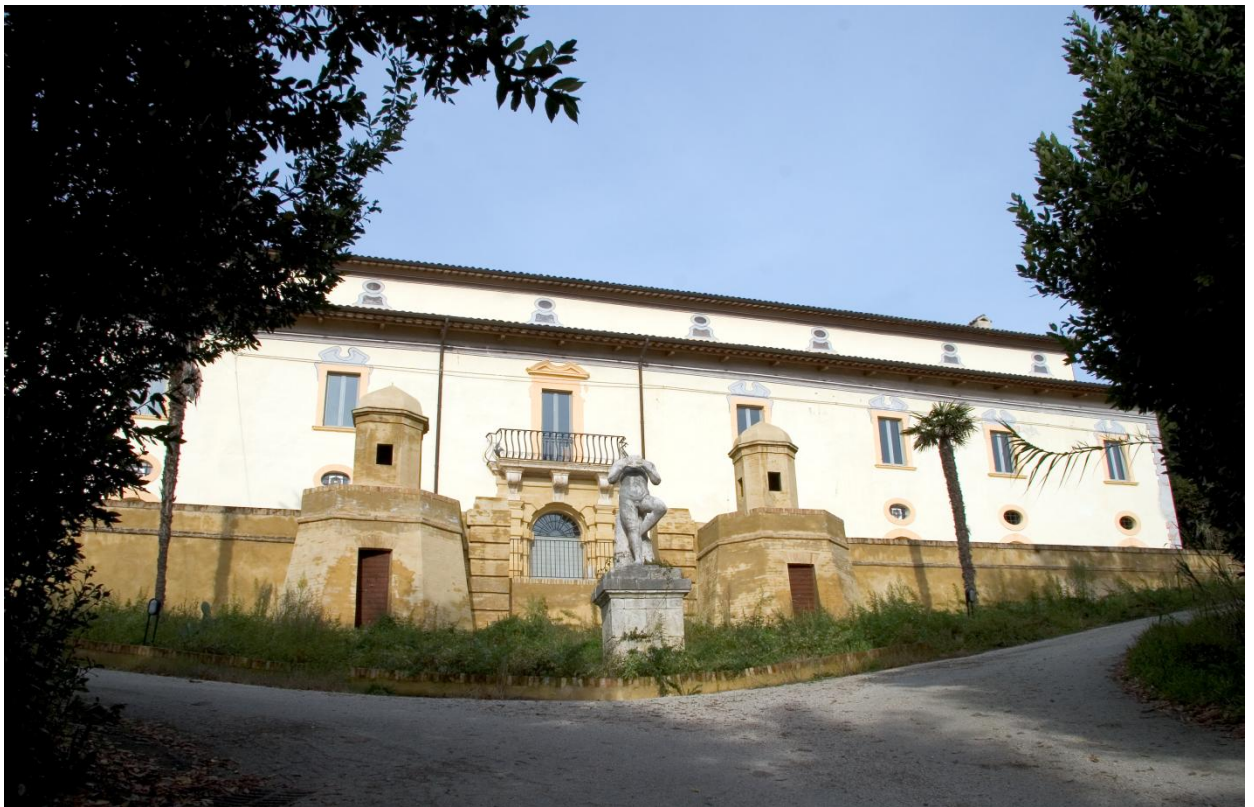
Villa Sgariglia di Campolungo, prima della realizzazione del Gazebo.
