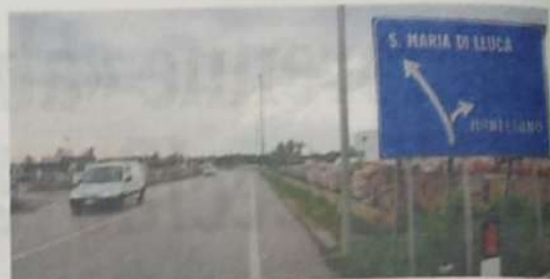
STRADA AD ALTO RISCHIO Lavori necessari per la sicurezza
