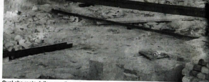
Quel che resta della cappella; a sinistra la parte smontata
