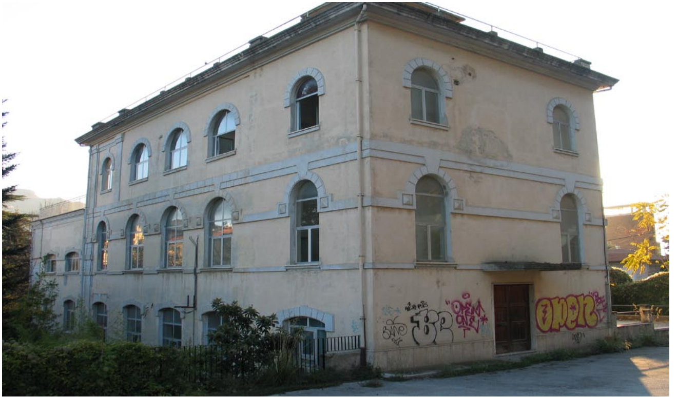
Edificio laterale del complesso Unes-Enel
