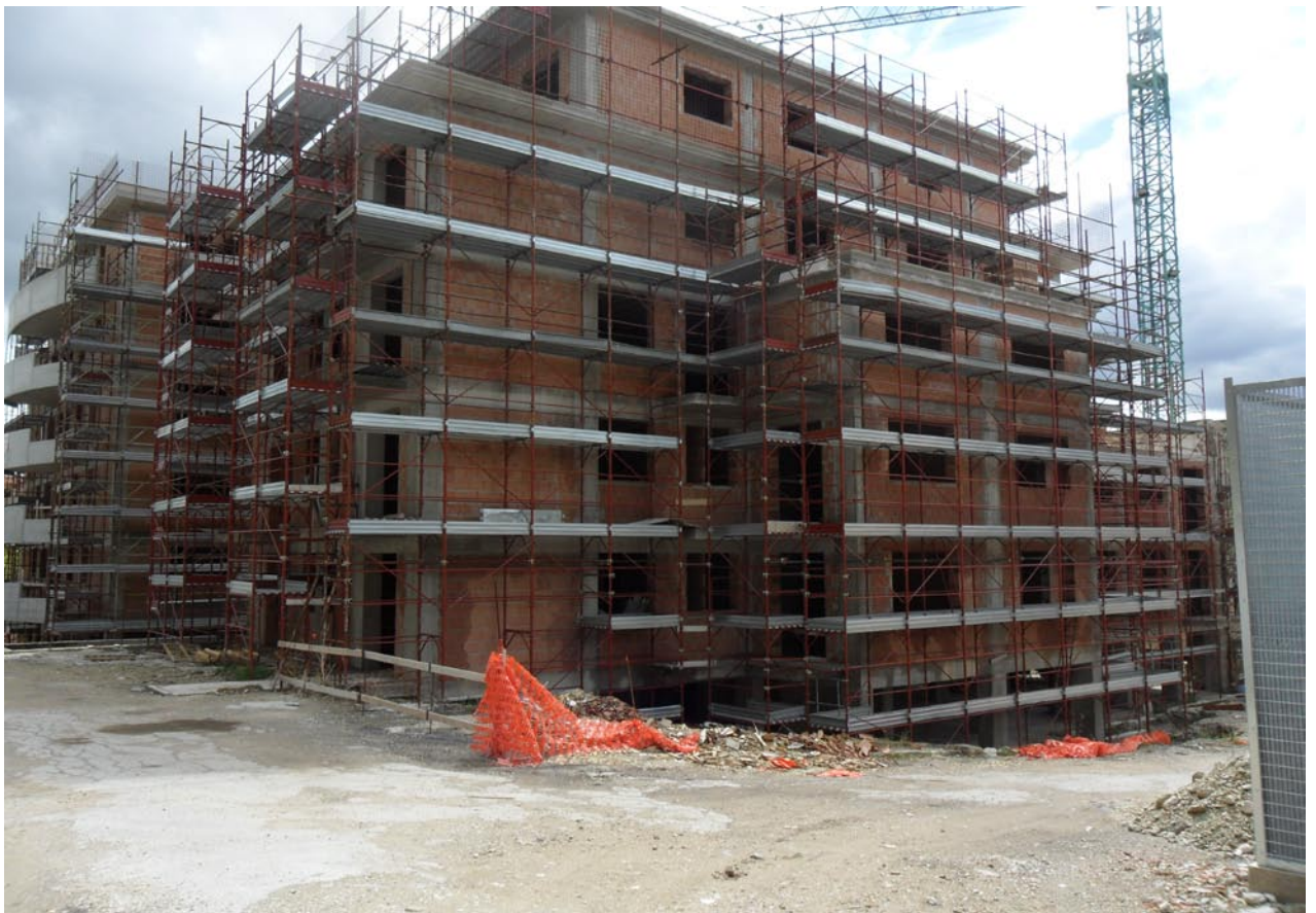
Attuale situazione del precedente edificio laterale
