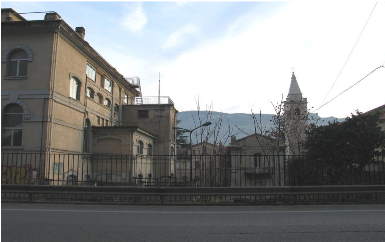
Complesso Unes-Enel dal retro
