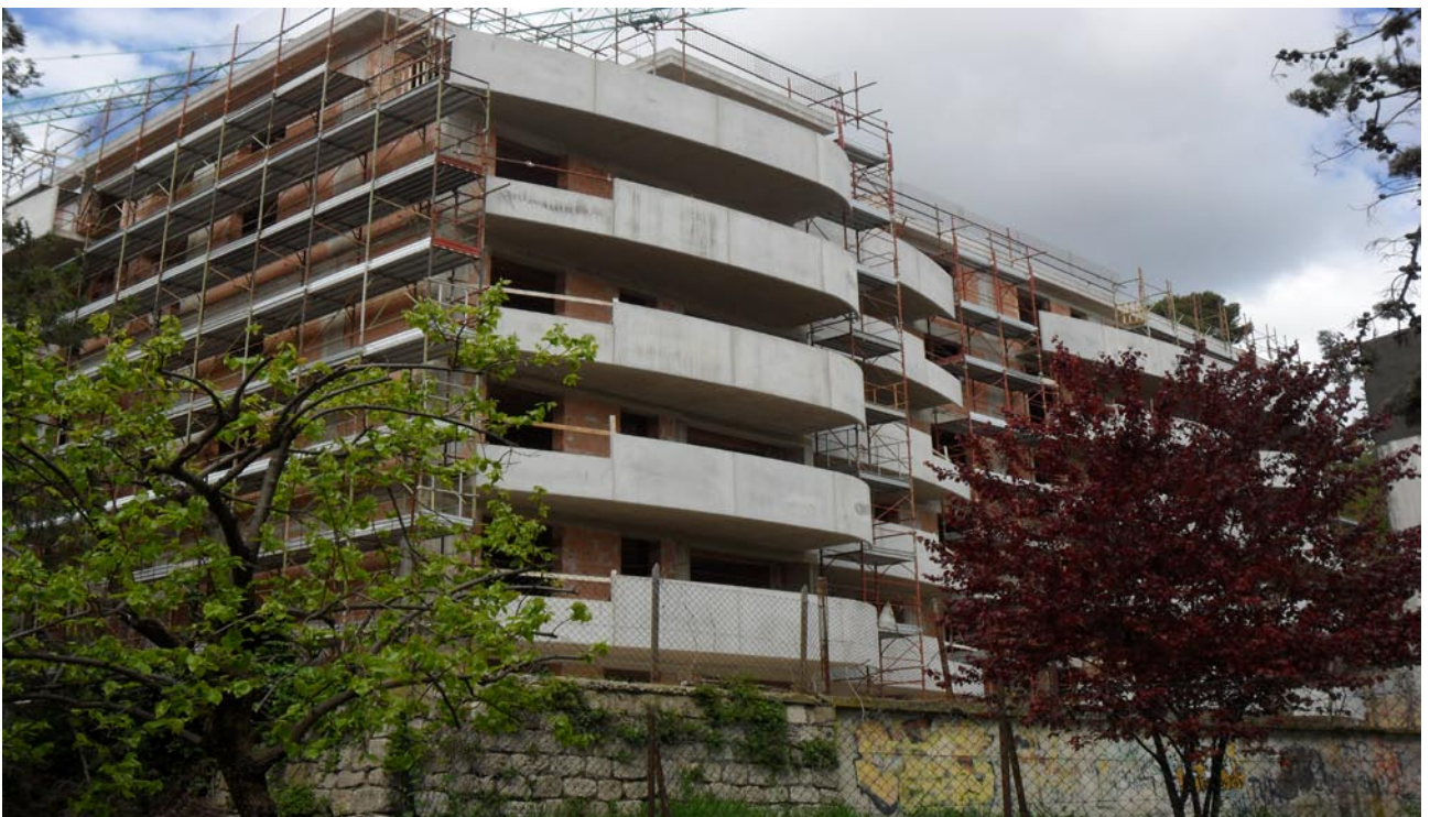
Edificio in fase di completamento
