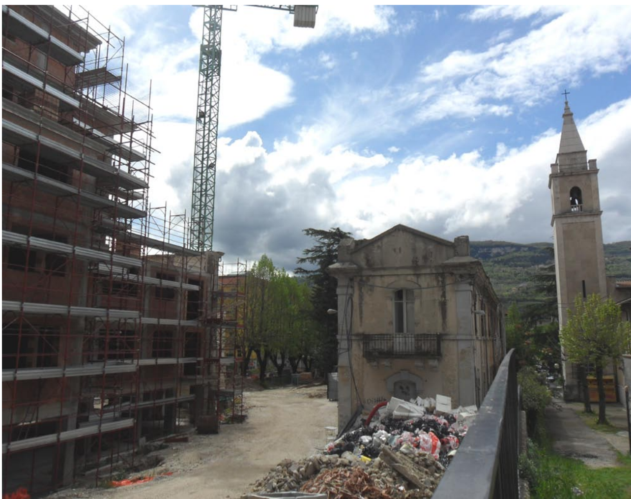
Situazione attuale del complesso dal retro
