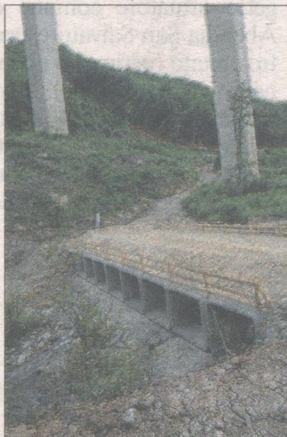
Petriolo Polemiche sul viadotto
