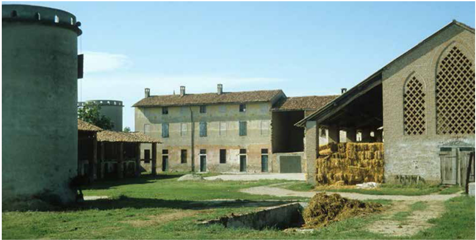
Fig. 28 - Cascina a Fiesco. Si noti che la casa dei salariati è abbandonata, Foto di Valerio Ferrari
