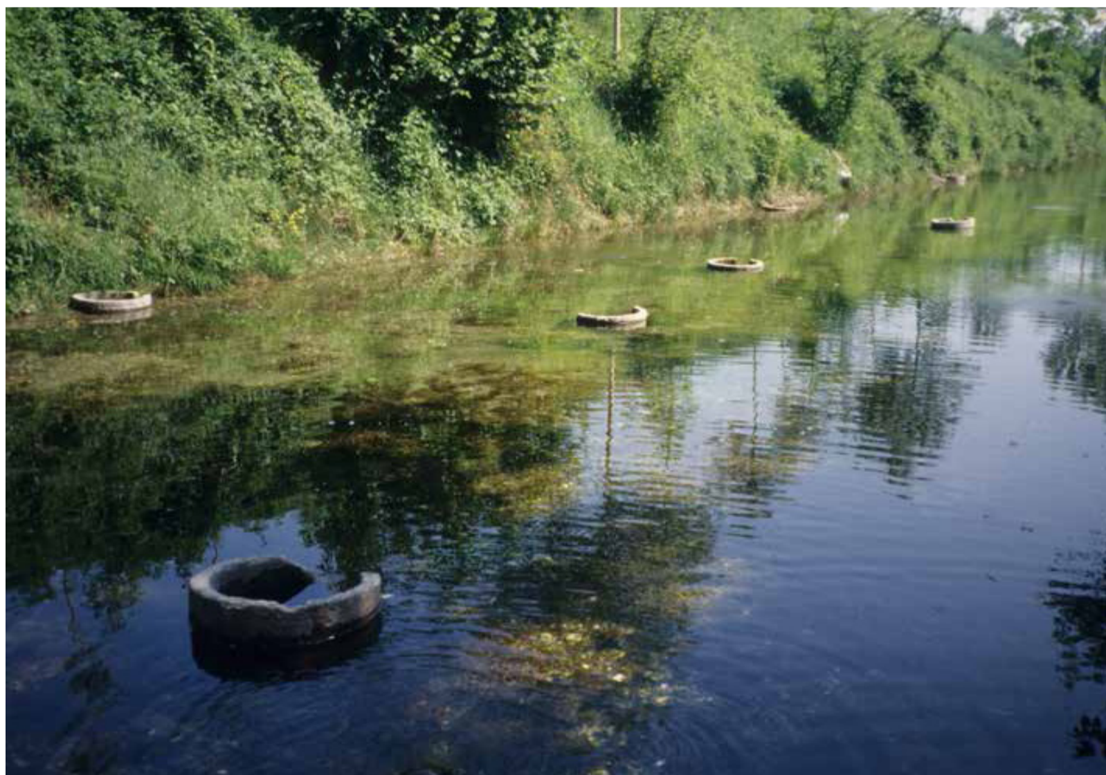
Fig. 44 - Capofonte di fontanile a Offanengo. Si notino i cilindri in cemento per la captazione dell'acqua, Foto di Valerio Ferrari
