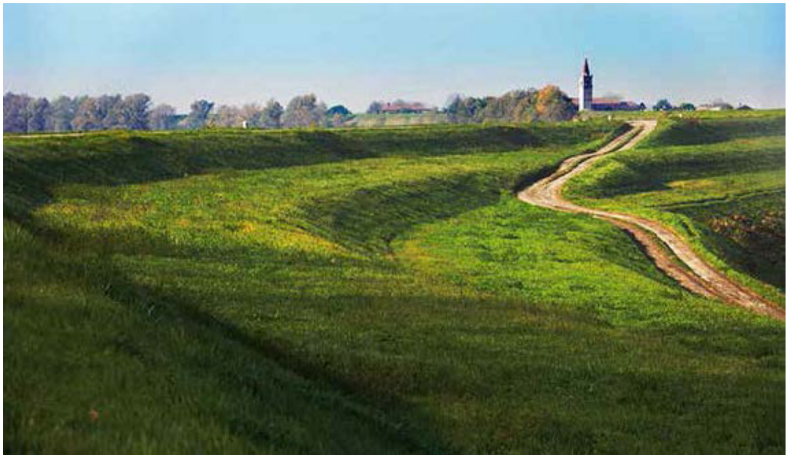
Fig. 11 - Argine sul Po a Guarda Veneta (Rovigo), Foto da : http://bur.regione.veneto.it/resourcegallery/photos/465_Guarda%20Veneta_ro_Panorama%20con%20argine.jpg
