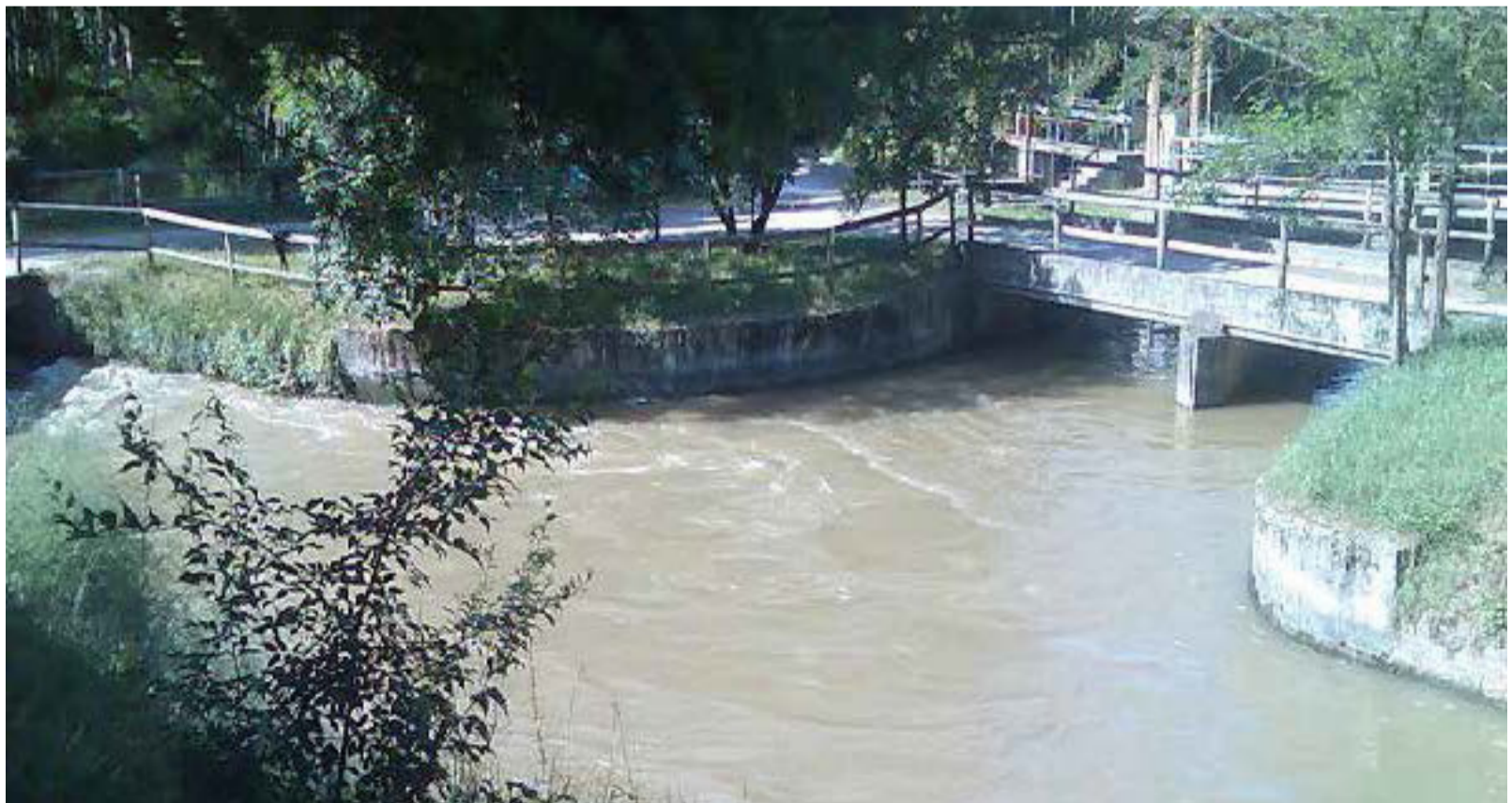
Fig. 25 - Il Naviglio Pallavicino soprappassato dal Canale Vacchelli al nodo delle Tombe morte, Foto da: www.cic.cr.it (per cortese concessione di Stefano Giovanni Loffi)
