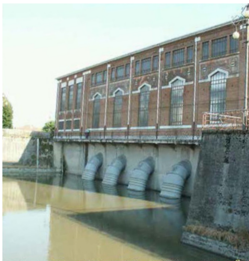
Fig. 15 - Le bocche di aspirazione dell'impianto idrovoro "Mondine" (Parmigiana Moglia) Foto da: http://it.wikipedia.org/wiki/File:Bonifica_parmigiana_moglia_collettori.jpg
