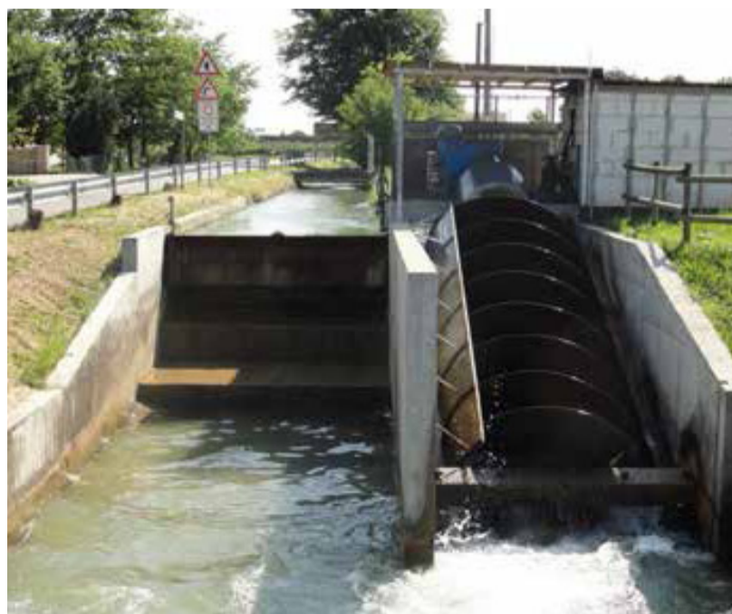
Fig. 67 - Coclea per sollevare l'acqua, www.cic.cr.it (per gentile concessione di Stefano Giovanni Loffi)
