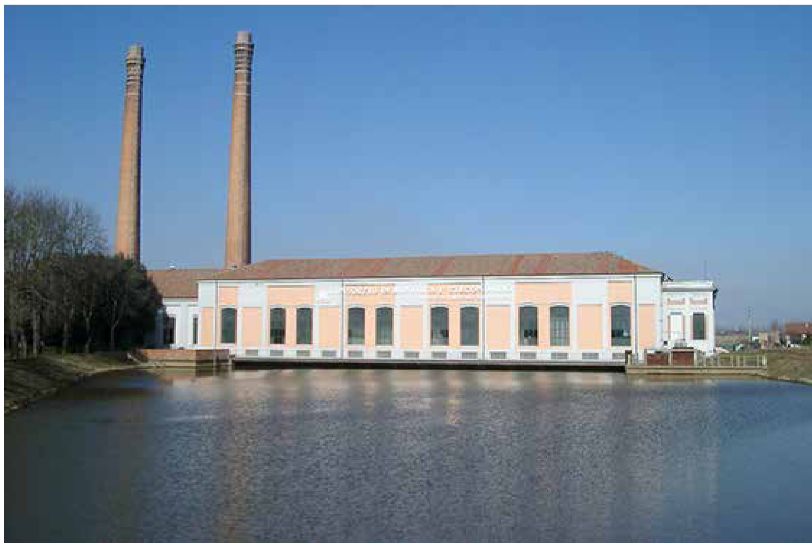
Fig. 17 - Impianto idrovoero di Acque Basse a Codigoro, Foto da: http://it.wikipedia.org/wiki/File:Acque_Basse_Codigoro.jpg
